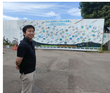
▲JR倶知安駅の新幹線工事現場。地元の子もたちと倶知安中学校美術部の生徒が描いた絵をフェンスに貼り付けた「くっちゃんアートプロジェクト2024」
