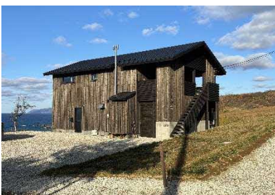
▲店舗兼工房の外観 別荘地の冷凍庫（氷室）として活用がされないまま保存されてきた建物を改築工事。資金集めはクラウドファンディングを活用。
