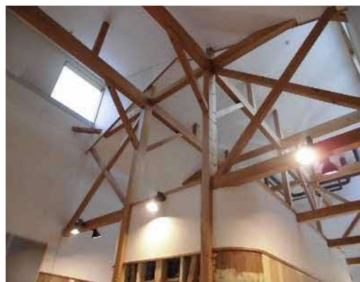
▲現在工事中のサテライトオフィス
