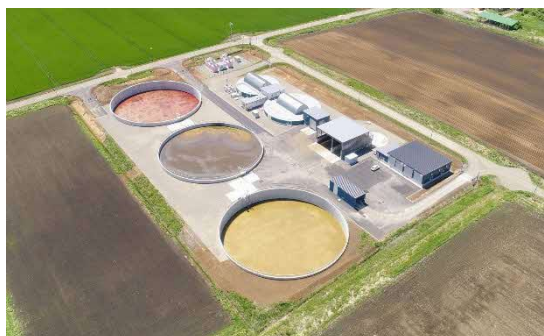
居辺地区にある集中バイオガスプラント
