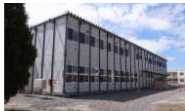
早来中学校仮設校舎
