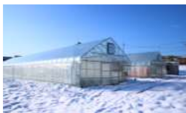
令和2年9月末に完成した施設
